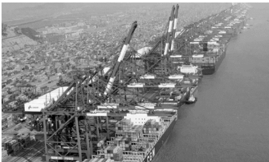
Рис. 2. Фото контейнерного терминала в Шанхае [10]
