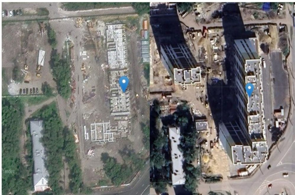
Рис. 3. спутниковые снимки строительной площадки многоэтажного здания на улице Шмидта г. Пензы
